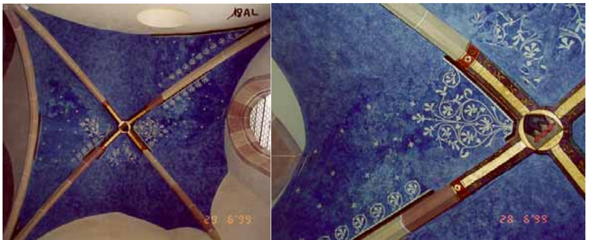
Après travaux de restauration
