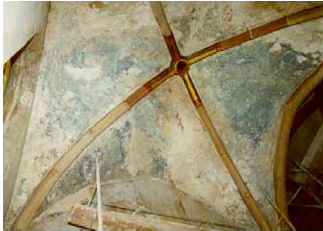
Avant travaux de restauration
