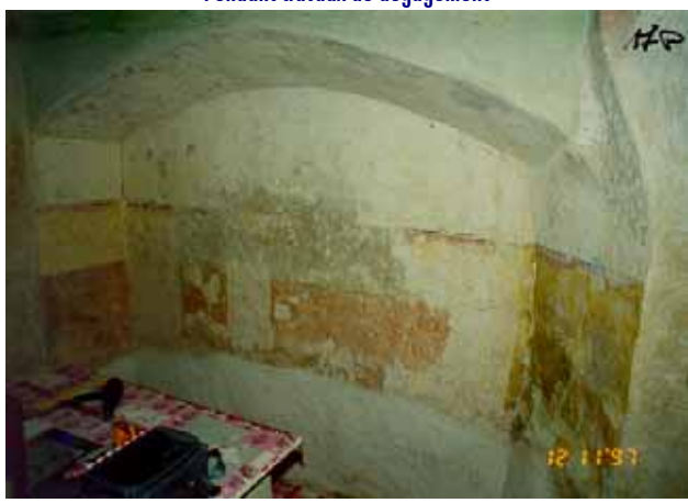
Pendant travaux de dégagement
