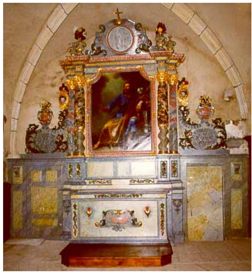
Après travaux de restauration
