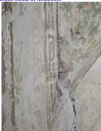
Pendant travaux de restauration
