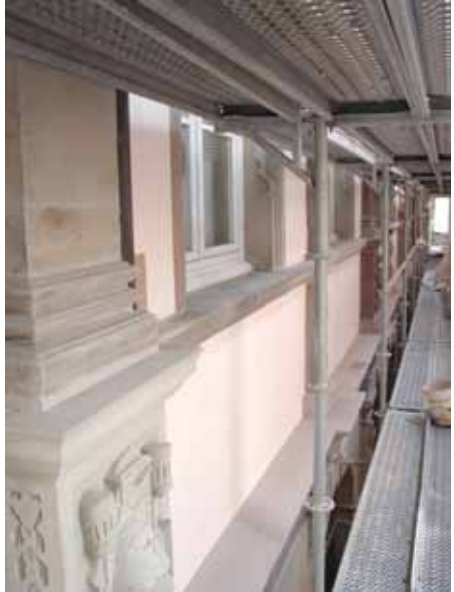
Pendant travaux de restauration
