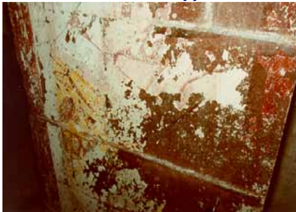
Pendant travaux de dégagement
