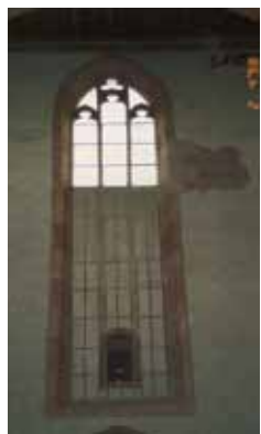
Détails après restauration
