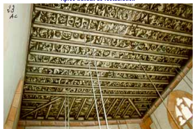
Après travaux de restauration
